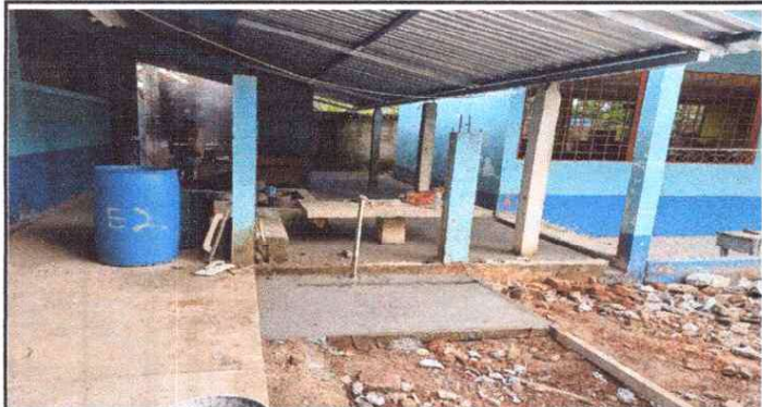
FOTO 1: CUBIERTA DE LAMINA, ESTRUCTURA DE TECHO Y SUSTITUCION DE PISO DE CONCRETO.
