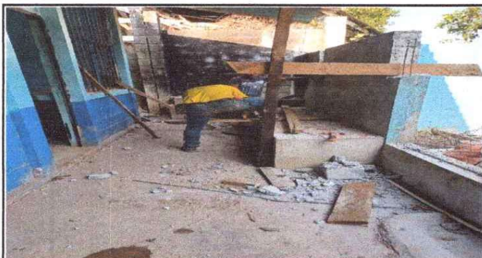
FOTO 3: Sustitución de ventana de metal de ventana.
