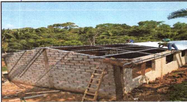
Foto 3: Instalación de estructura metálica del techado
