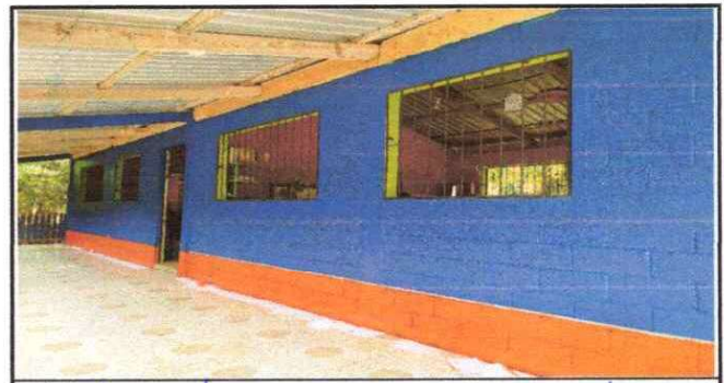
Foto 6: Mantenimiento de pintura
