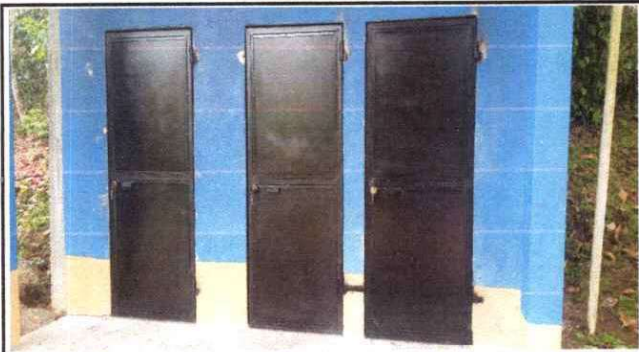
Foto 1: Finalización e instalación de las puertas de metal
