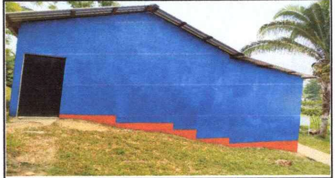
Foto 2: Mantenimiento de pintura
