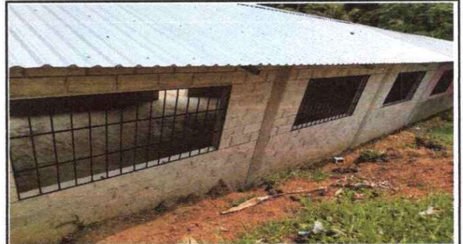
Foto 4: Finalización e instalación de balcones
