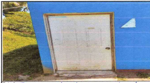
Foto 6: Reparación de la puerta de madera por metal
