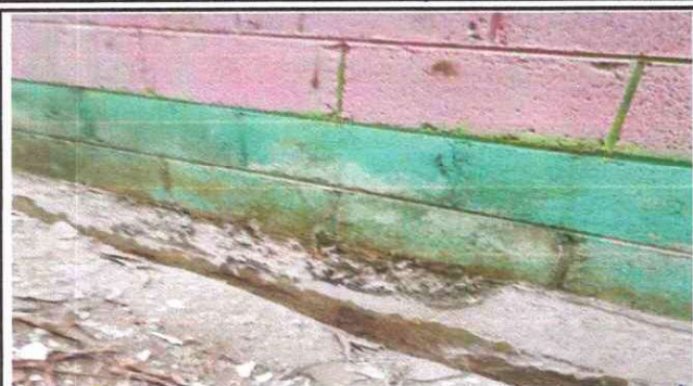
Foto 1: Reparación de la pared de la escuela
