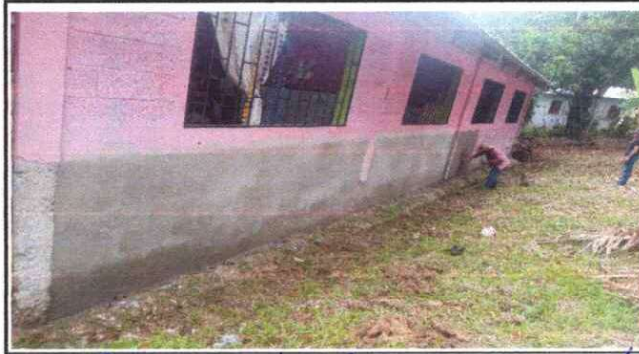
Foto 4: Reparación con repello de la parte de atrás de la escuela
