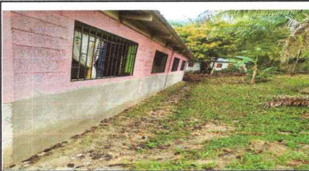
Foto 3: Finalización del repello de la pared de atrás de la escuela
