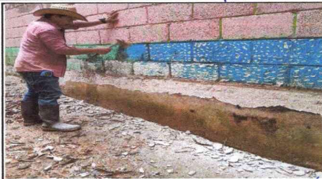
Foto 2: Reparación de la pared de la escuela
