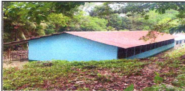
Foto 4: Cambio del techado de toda la escuela.
