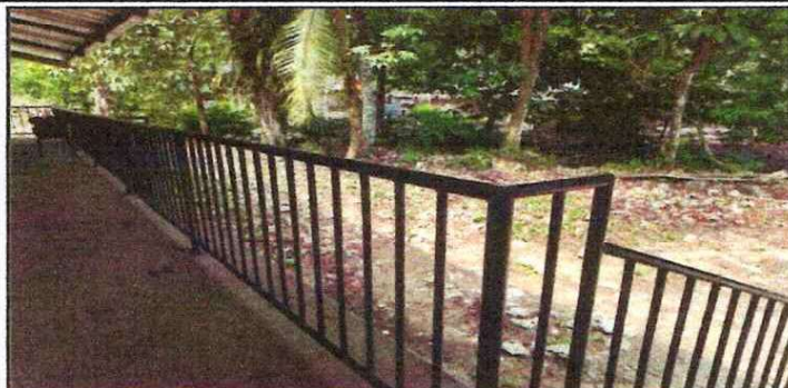
Foto 2: Mantenimiento y pintura de balcones, puertas y barandas
