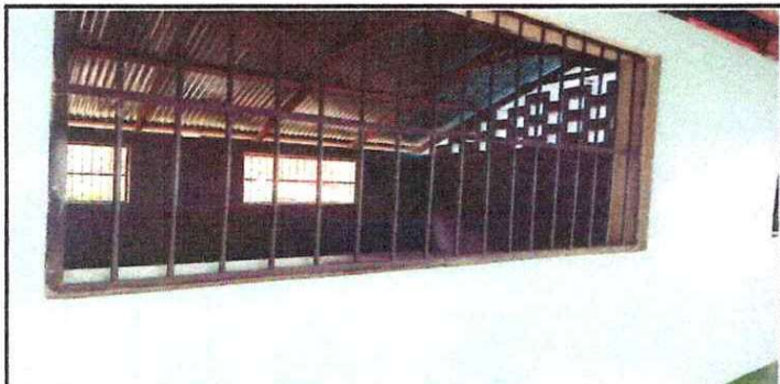
Foto 3: Cambio de balcones de madera por balcones de metal.
