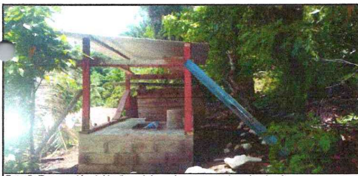
Foto 5: Reparación del baño y del camino que conduce hacia el
