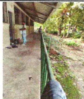
lijado y pintado de balcones, puertas y barandas de metal.
