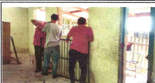
instalacion de balcones de metal.
