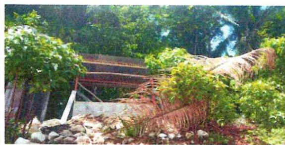
reparacion del baño letrino
