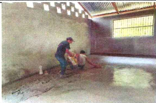
fundicion de torta de cemento
