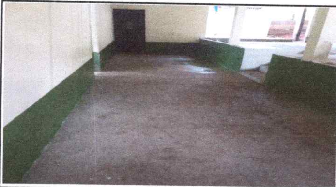
FOTO 3: PINTURA EN MUROS INTERIORES Y EXTERIORES
