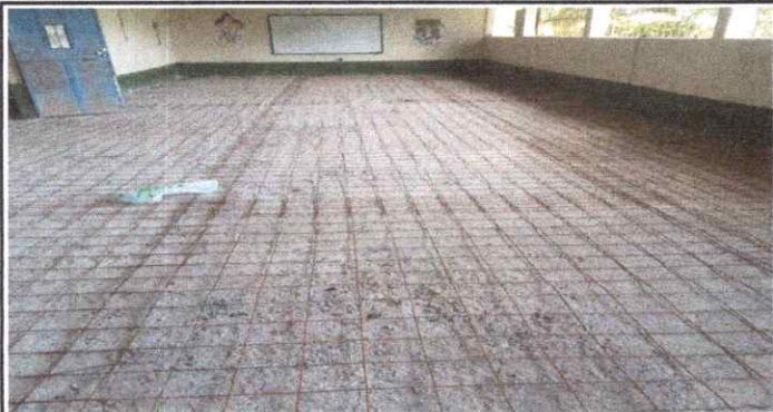
FOTO 1: Sustrucción de piso de cemento líquido
