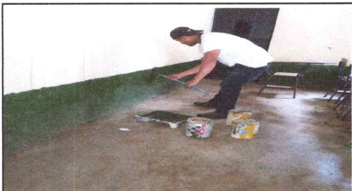
FOTO 3: PINTURA EN MUROS INTERIORES Y EXTERIORES
