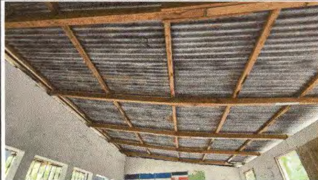
Foto 8: MODULO "A" SUMINISTRO E INSTALACION DE ESTRUCTURA METALICA EN AULA
