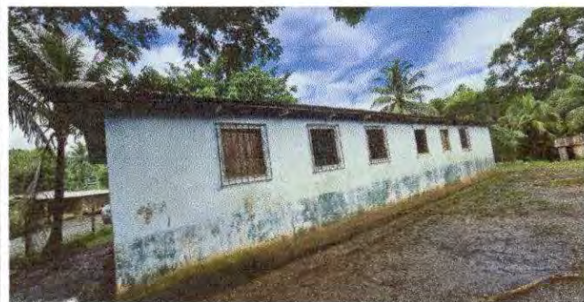
Foto 10: SUMINISTRO Y COLOCACION DE LAMINA
