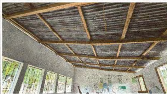
Foto7: . MODULO "A" SUMINISTRO E INSTALACION DE LAMINA
