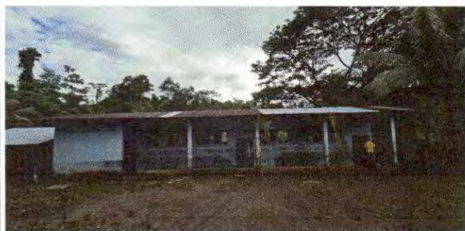
Foto 1: . MODULO "A" REMOZAMIENTO DE TECHO
