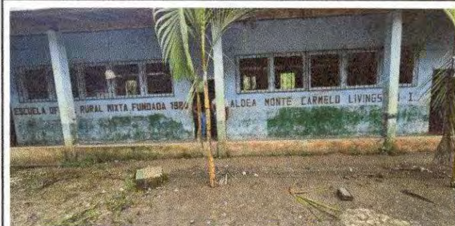
Foto 4: MODULO "A" REMOZAMIENTO DE TECHO
