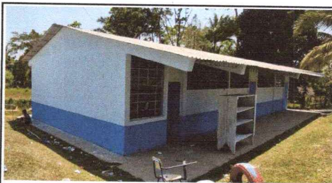
FOTO 4: PINTURA EN MUROS INTERIORES Y EXTERIORES
