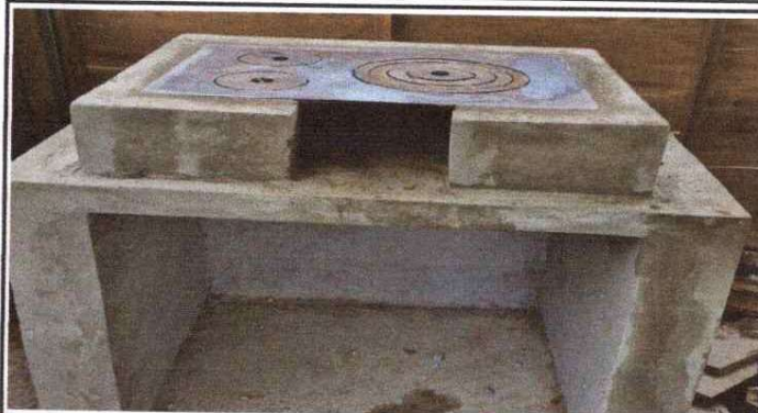
FOTO 2: SUSTITUCIÓN DE PLANCHA DE METAL DE 3 HORNILLAS
