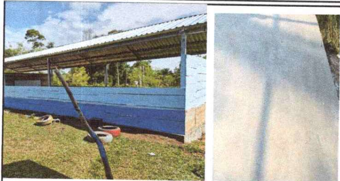
FOTO 1: Sustrucción de Lámina por lámina troquelada calibre 26 aluzinc, Sustrucción de Estructura de soporte de madera por metal, Sustrucción de torta de concreto.
