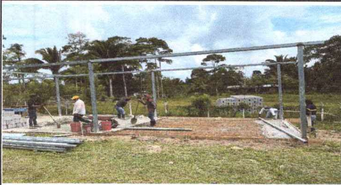
FOTO 1: Sustitución de Lámina por lámina troquelada calibre 26 aluzinc, Sustitución de Estructura de soporte de madera por metal, Sustitución de torta de concreto.
