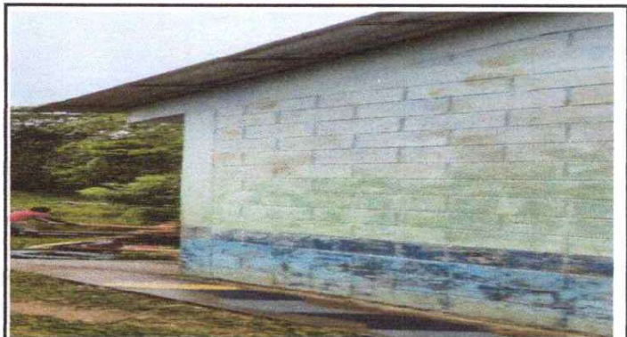
FOTO 4: PINTURA EN MUROS INTERIORES Y EXTERIORES
