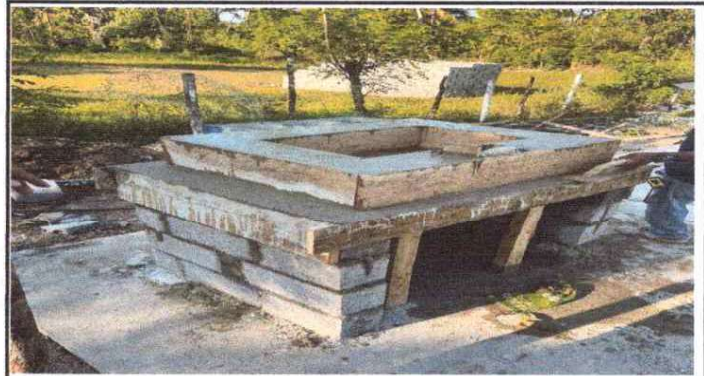
FOTO 2: SUSTITUCIÓN DE PLANCHA DE METAL DE 3 HORNILLAS
