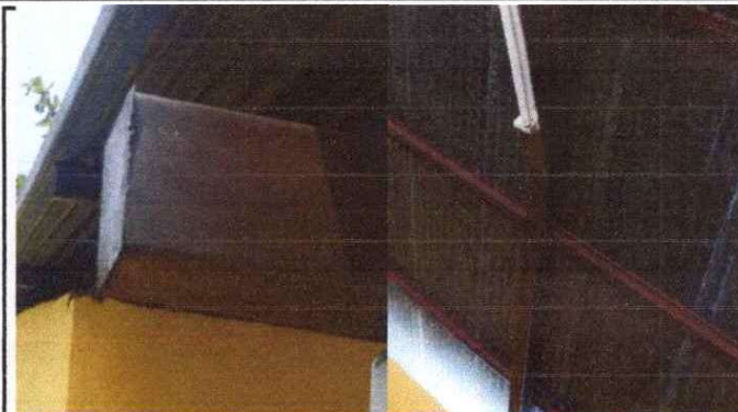
MANTENIMIENTO DE ESTRUCTURA METÁLICA
