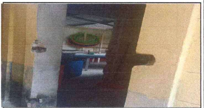
SUSTITUCIÓN DE PUERTA METÁLICA
