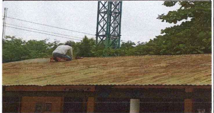
MANTENIMIENTO DE LÁMINA
