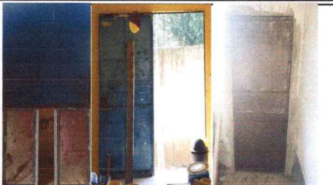
MANTENIMIENTO DE PUERTAS
