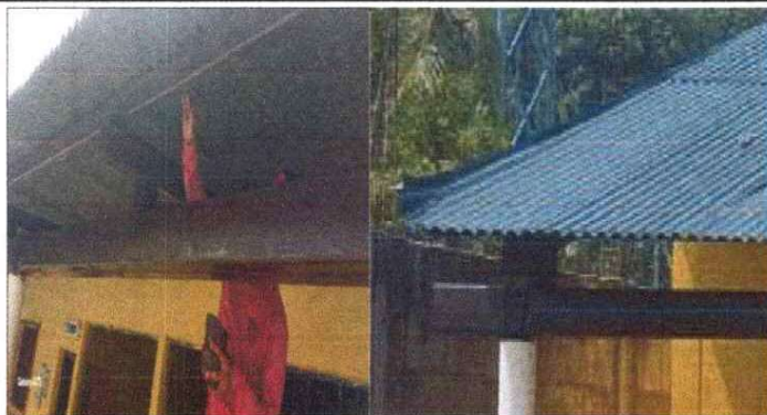
MANTENIMIENTO DE ESTRUCTURA DE TECHO
