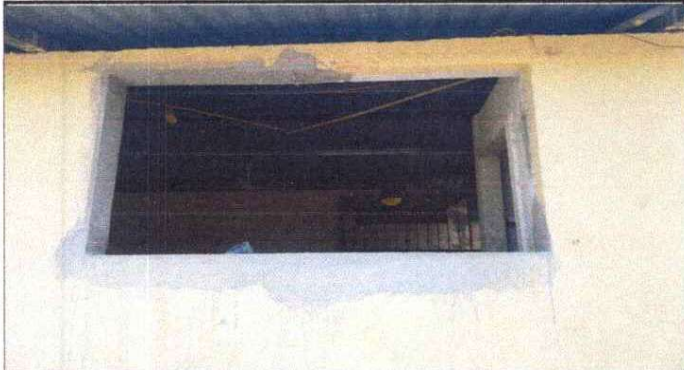
SUSTITUCION DE DOS VENTANAS DE MADERA POR DOS BALCONES METALICOS EN AULA 2 DE EODP ANEXA A EORM
