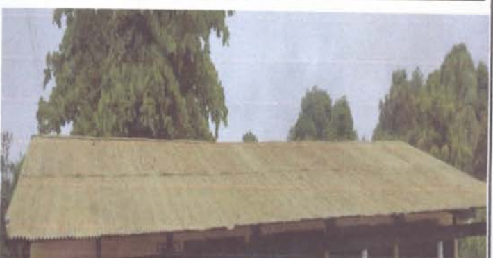
Mantenimiento de lámina lijada y pintada EORM
