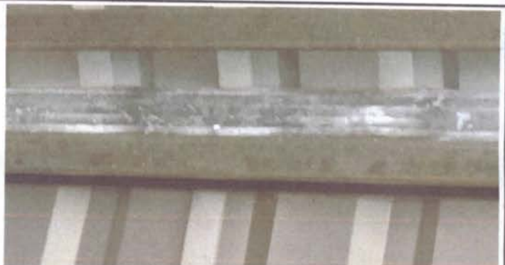
sustitución de costaneras EODP anexa a EORM
