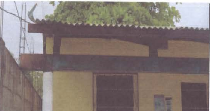
mantenimiento a estructura soporte de metal EORM
