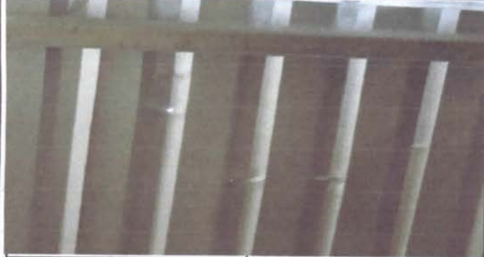
sustitución de lámina, por lamina troquelada aluzinc calibre 26 EODP anexa a EORM
