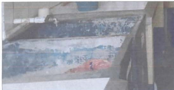
REPARACIÓN DE COCINA: sustitucion de pila de un lavadero
