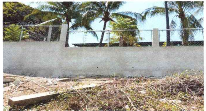
FINALIZACION DEL MURO PERIMETRAL
