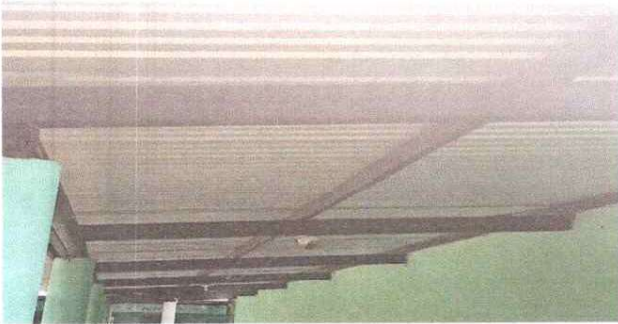
INSTALACION DE LAMINAS TROQUELADAS CALIBRE 26
