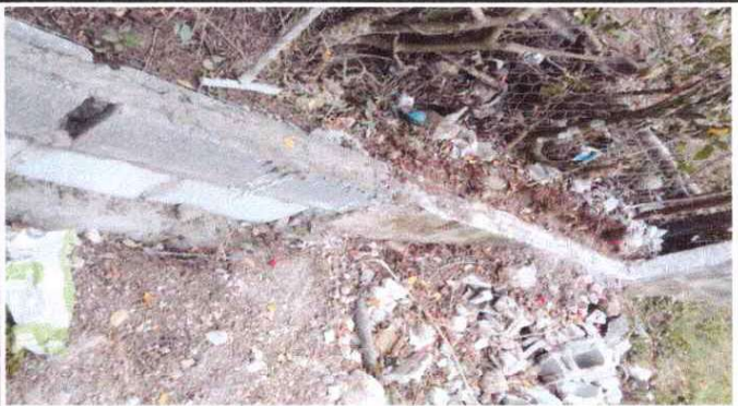
COLOCACION DE BLOK DE MURO PERIMETRAL
