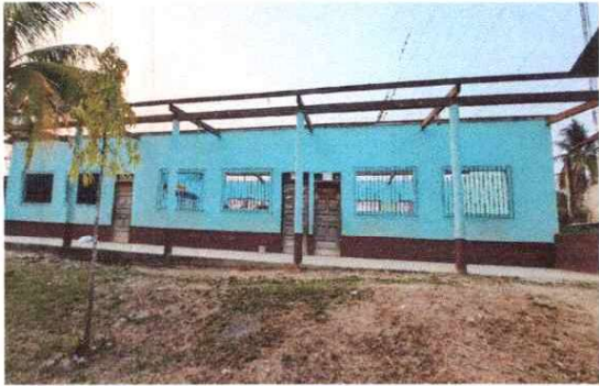
DESINSTALACION DE LAMINAS EXISTENTES
