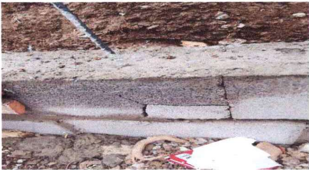
TRABAJO DE MURO PERIMETRAL
