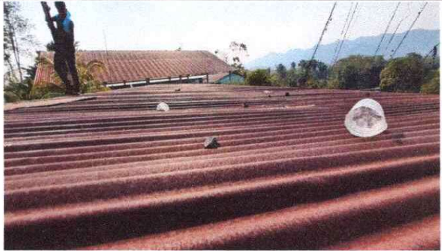
DESINSTALACION DE LAMINAS
