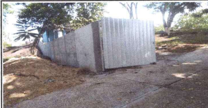
FOTO 2: Reparación de muro perimetral de block
