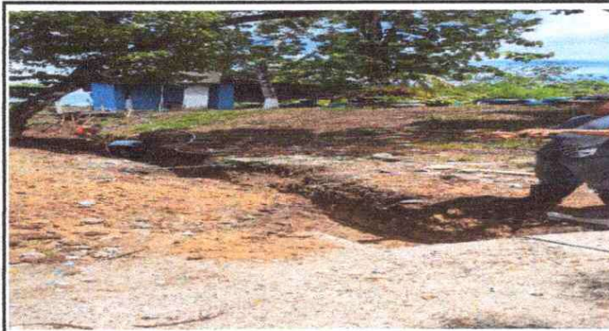
FOTO 2: Reparación de muro perimetral de block
