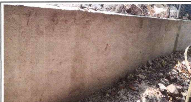
REPELLO EN MURO
