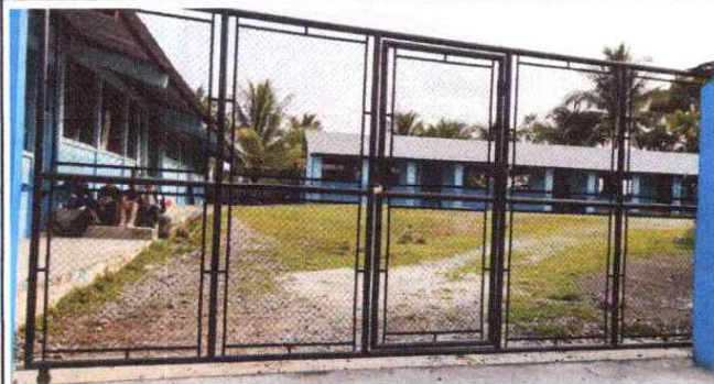
MANTENIMIENTO A PORTONES DE METAL
