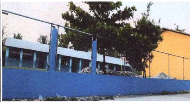
PINTURA EN MUROS EXTERIORES E INTERIORES
