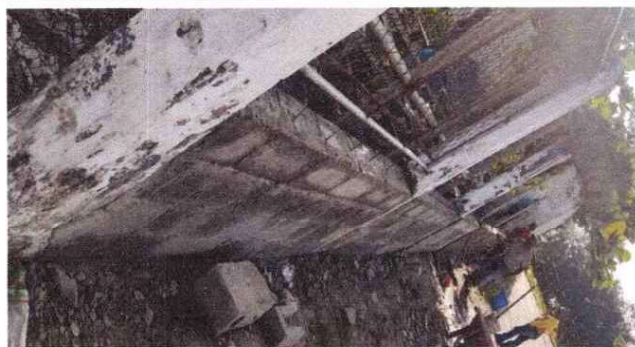
REPARACIÓN DE MURO PERIMETRAL DE BLOCK CON TUBO HG Y MALLA GALVANIZADA, SOLERAS INTERMEDIAS Y COLUMNAS
