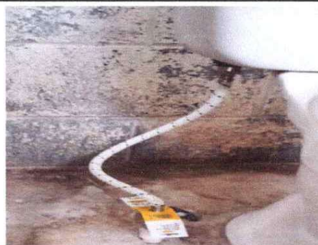
SUSTITUCIÓN DE ACCESORIOS INODORO (CONTRA LLAVE, TUBO DE ABASTO Y TANQUE)
