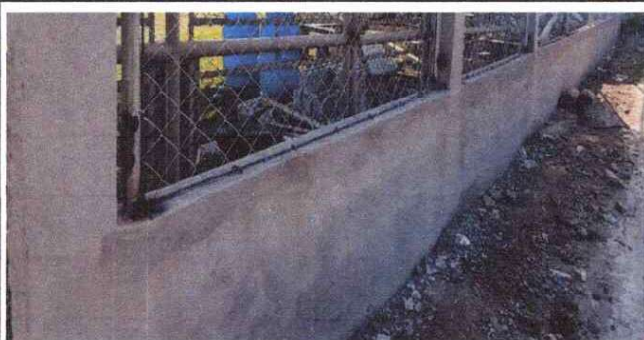
REPELLO EN MURO
