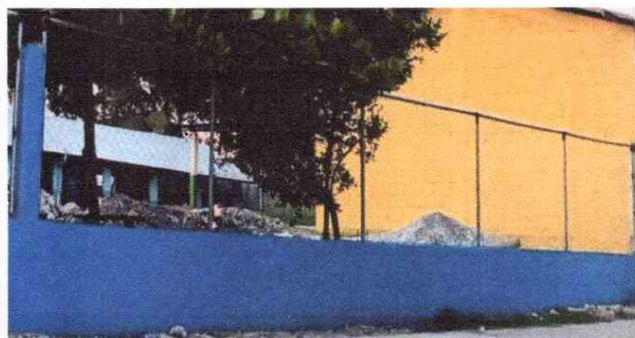
PINTURA EN MUROS EXTERIORES E INTERIORES
