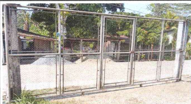
MANTENIMIENTO A PORTONES DE METAL
