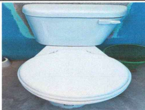
INSTALACIÓN DE INODORO
