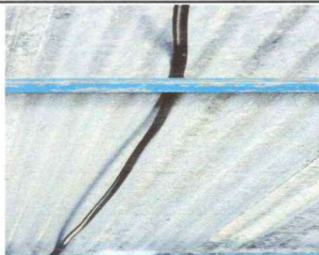
SUSTITUCIÓN DE DUCTO ELÉCTRICO + ACCESORIOS
