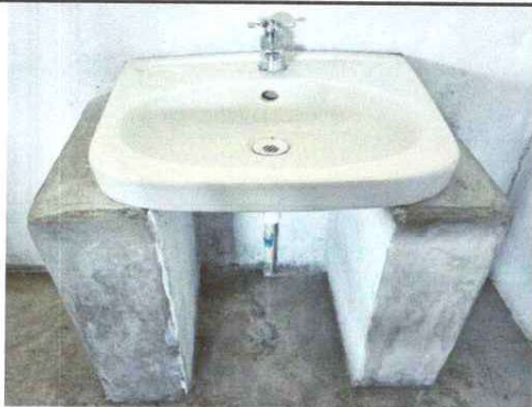
INSTALACIÓN DE LAVAMANOS
