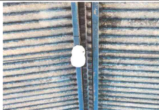
SUSTITUCIÓN DE LAMPARASTIPO LED
