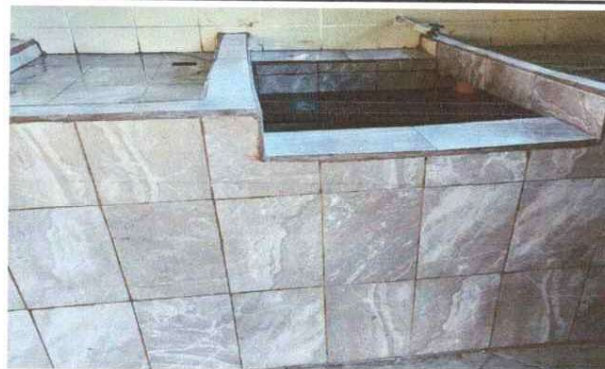
SUSTITUCIÓN DE PILA DE CEMENTO DE UN LAVADERO
