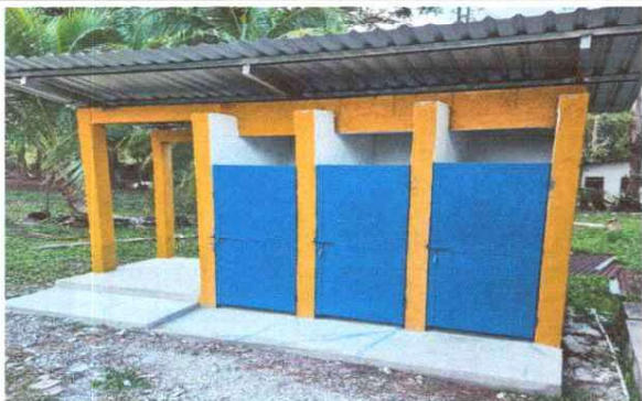
SUSTITUCIÓN DE PUERTAS EN SERVICIOS SANITARIOS
