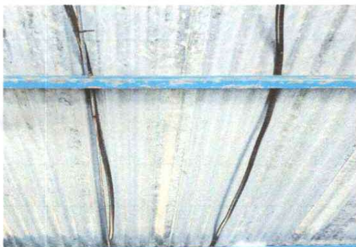
REPARACIÓN CABLEADO ELECTRICO
