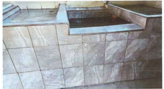
SUSTITUCIÓN DE PILA DE CEMENTO DE UN LAVADERO
