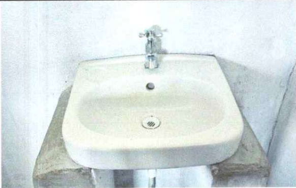
INSTALACIÓN DE LAVAMANOS
