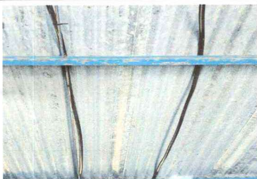
REPARACIÓN CABLEADO ELECTRICO
