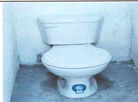
INSTALACIÓN DE INODORO
