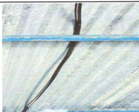
SUSTITUCIÓN DE DUCTO ELÉCTRICO + ACCESORIOS
