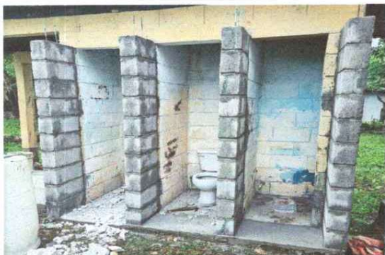
SUSTITUCIÓN DE PUERTAS EN SERVICIOS SANITARIOS
