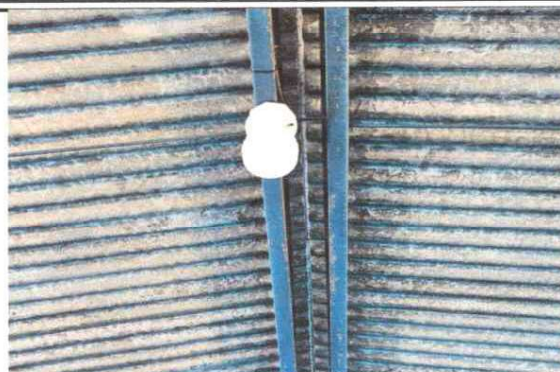
SUSTITUCIÓN DE LAMPARASTIPO LED
