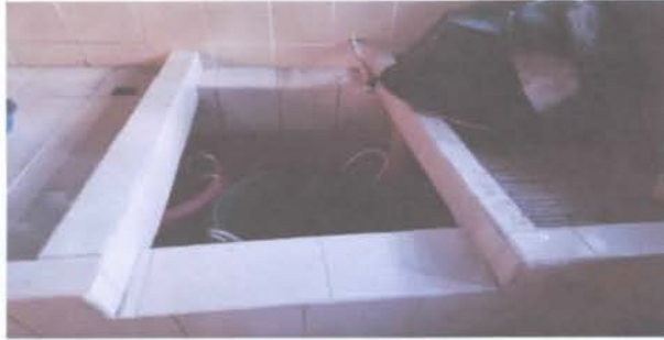
Sustitución de pila de dos lavaderos
