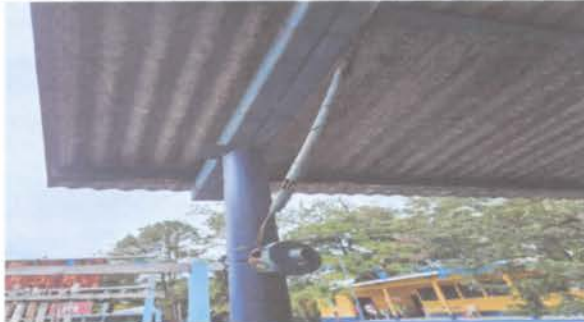
Reparación de cableado eléctrico
