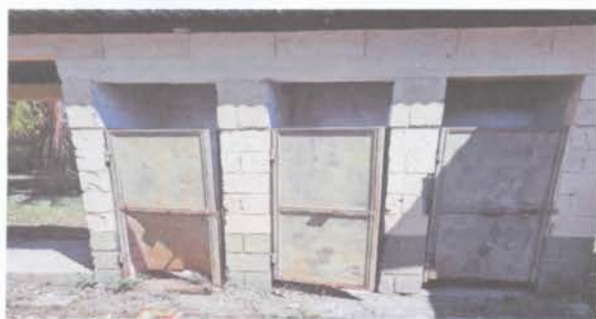
Sustitución de puerta en servicios sanitarios
