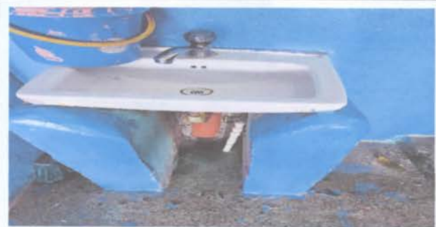
Instalación de lavamanos
