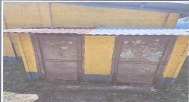
Mantenimiento a estructura (lijado, cambio de tubo , cepillado, sujeciones, aplicación de pintura) a puertas servicios sanitarios
