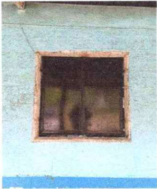
Sustitución de ventana de madera por ventana de metal aula 3
