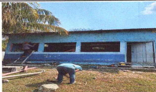
Sustitución de puerta de madera por, puerta de metal, y ventanas de madera por ventanas de metal aula 4
