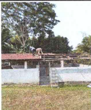
Sustitución de lámina, por lámina troquelada aluzinc calibre 26, sustitución de estructura de madera por, estructura de metal, sustitución de puerta de madera por puerta de metal. COCINA
