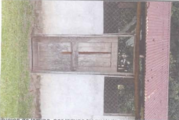
Sustitución de lamina, por lamina troquelada aluzinc calibre 26, sustitución de estructura de madera por, estructura de metal, sustitución de puerta de madera por puerta de metal. COCINA
