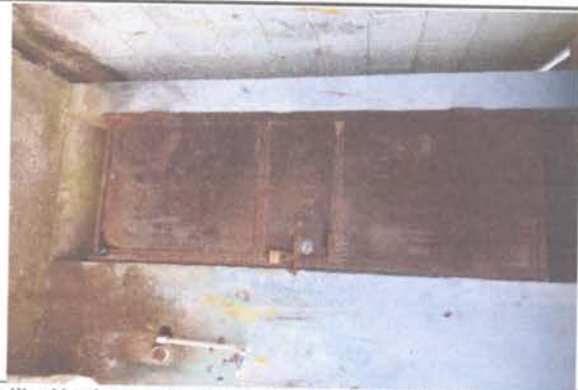
Sustitución de puertas de servicios sanitarios 1,2,3,4
