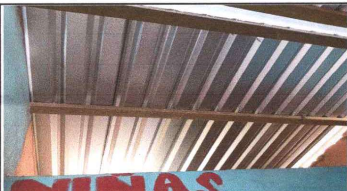
MANTENIMIENTO A ESTRUCTURA DE TECHO
