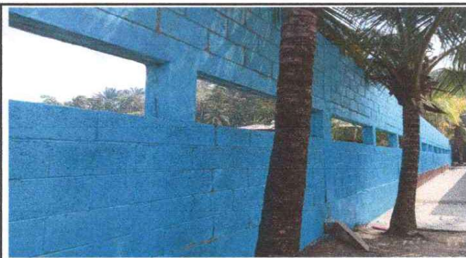
REPARACIÓN DE MURO PERIMETRAL DE BLOCK
