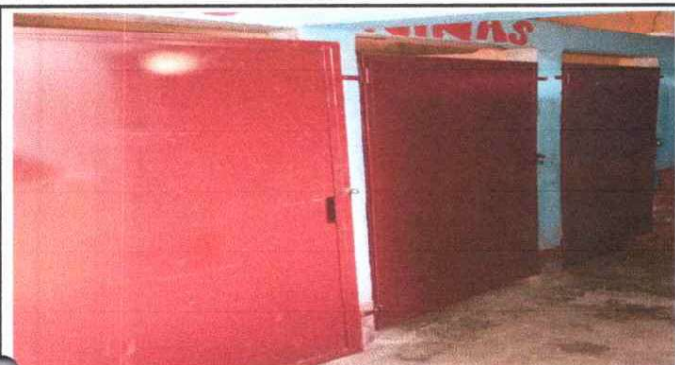
SUSTITUCIÓN DE PUERTAS EN SERVICIOS SANITARIOS
