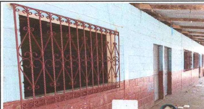
SUSTITUCIÓN DE BALCONES DE METAL
