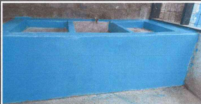
SUSTITUCIÓN DE PILA DE CEMENTO
