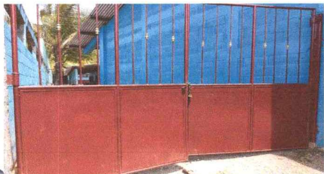
MANTENIMIENTO A PORTONES DE METAL
