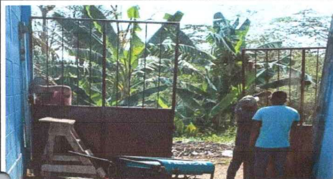
MANTENIMIENTO A PORTONES DE METAL
