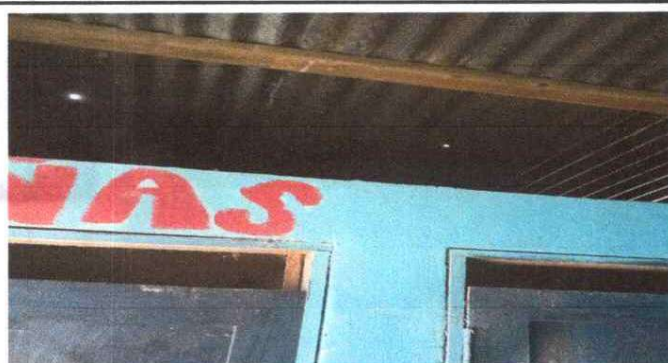
MANTENIMIENTO A ESTRUCTURA DE TECHO
