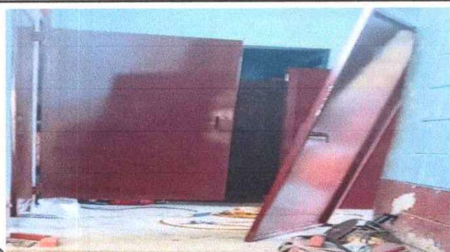
SUSTITUCIÓN DE PUERTAS EN SERVICIOS SANITARIOS
