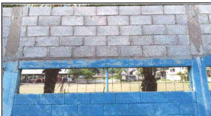
REPARACIÓN DE MURO PERIMETRAL DE BLOCK
