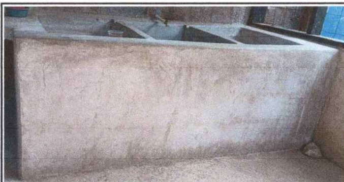
SUSTITUCIÓN DE PILA DE CEMENTO
