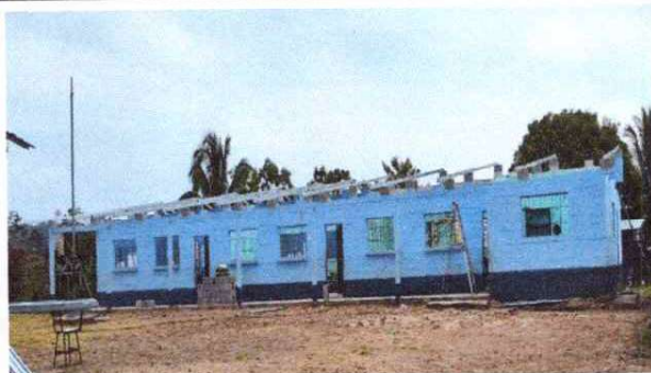
DESTITUCION DE ESTRUCTURA DE SOPORTE DE MADERA POR METAL
