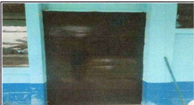
Foto 4: Finalización de puertas
