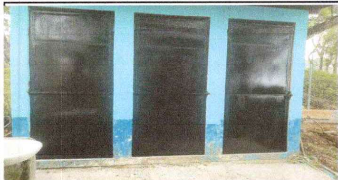
Foto 1: Finalización de puertas
