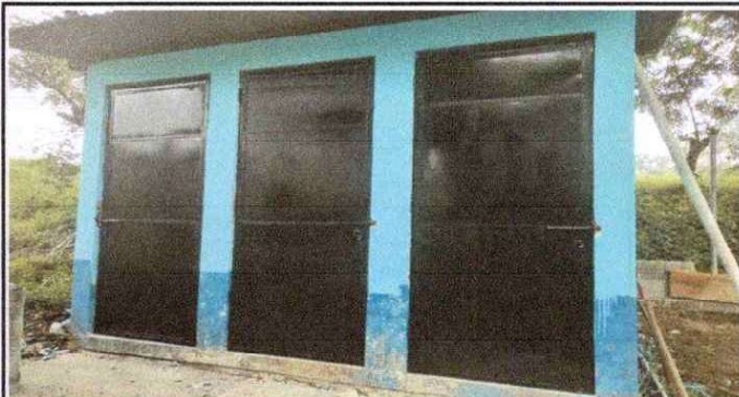
Foto 2: Finalización de puertas
