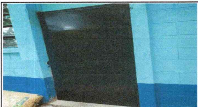
Foto 3: Finalización de puertas
