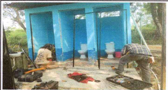
Foto 2: Remodelacion de puertas
