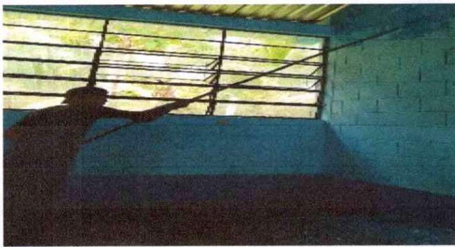
Foto1: Renovacion de pintura.
