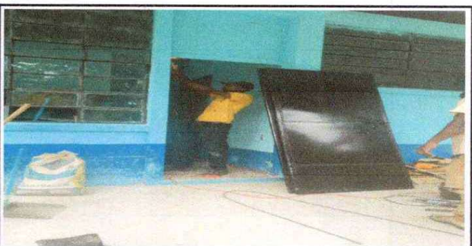
Foto 6: Remodelacion de puertas
