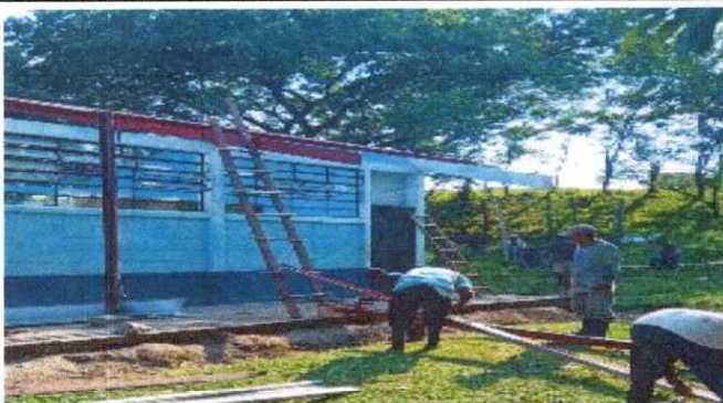
Foto 3: Renovacion de pintura.
