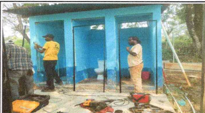
Foto 3: Remodelacion de puertas
