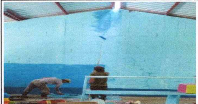
Foto 2: Renovacion de pintura.
