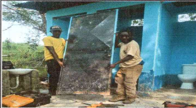
Foto1: Remodelacion de puertas
