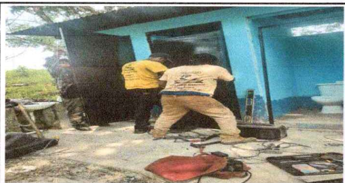
Foto 5: Remodelacion de puertas
