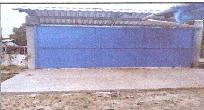
FOTOGRAFIA 6: MANTENIMIENTO A PORTONES DE METAL
