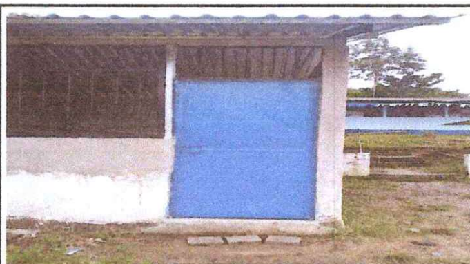
FOTOGRAFIA 4: SUSTITUCION DE PUERTA
