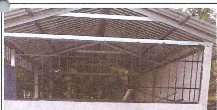
FOTOGRAFIA 5: SUSTITUCION DE BALCONES DE METAL
