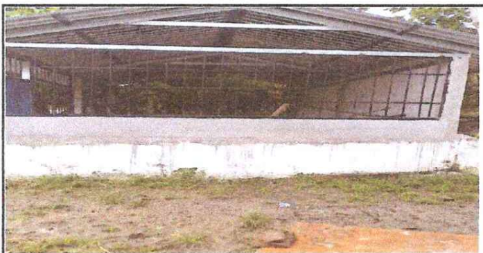
FOTOGRAFIA 3: AMPLIACION DE MURO EN COCINA CON REFUERZO ESTRUCTURAL
