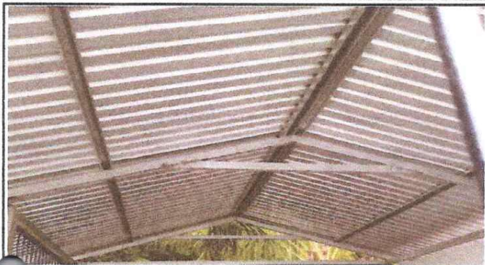
FOTOGRAFIA 1: SUSTITUCION DE LAMINA POR LAMINA ALUZINC CALIBRE 26
