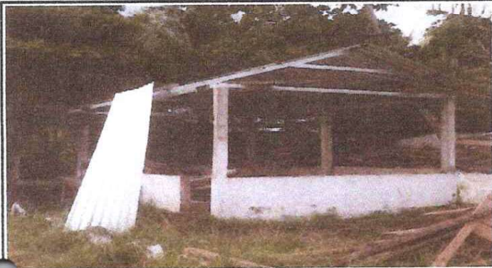
FOTOGRAFIA 1: SUSTITUCION DE LAMINA POR LAMINA ALUZINC CALIBRE 26
