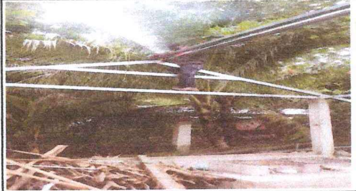
FOTOGRAFIA 2: SUSTITUCION DE ESTRUCTURA DE SOPORTE DE MADERA, POR METAL
