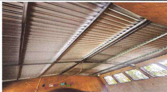
Foto 4 Sustitucion de estructura de soporte de metal por metal
