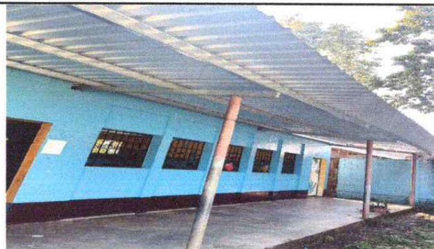
Foto 6 Sustitucion de soporte de metal por metal
