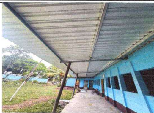
Foto 2. Sustitución de lámina, por lamina troquelada aluzinc calibre 26
