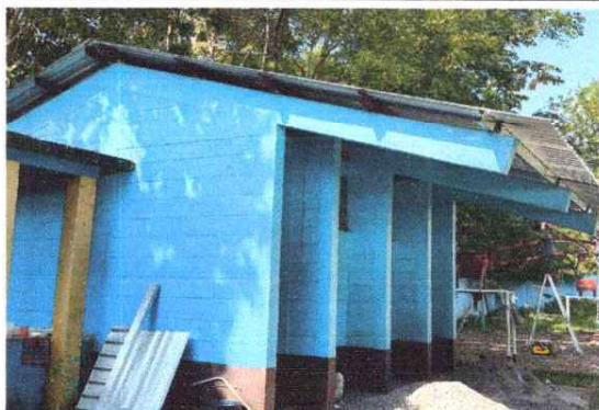
Foto 3 Sustitucion de lamina, por lamina troquelada calibre 26
