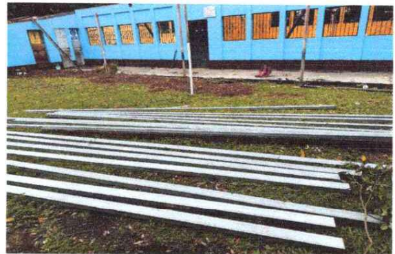
Foto 4 Sustitucion de estructura de soporte de metal por metal
