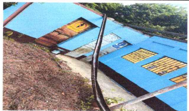
Foto 6 Sustitucion de estructura de metal por metal
