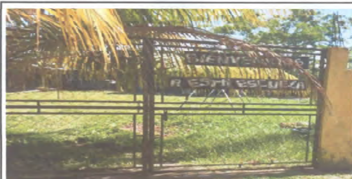
Foto 6. Mantenimiento a portones de metal
