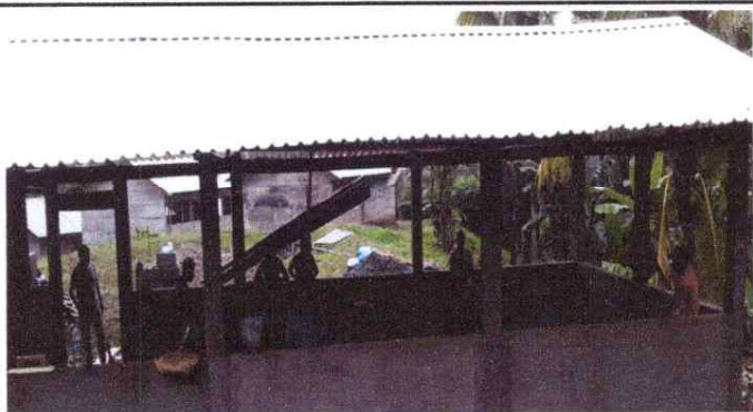
1. Lámina troquelada calibre 26 instalada
