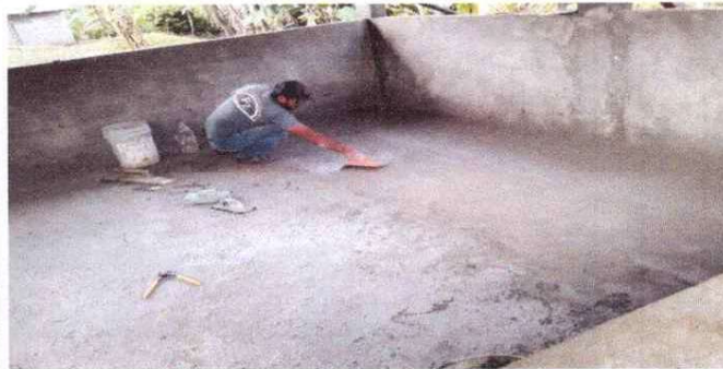
2. Aplicación de piso de torta de concreto
