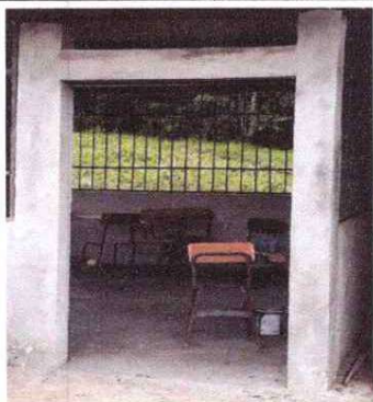
3. Desinstalación de puerta de madera
