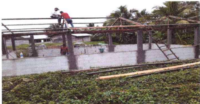
1. Lámina existente desinstalada
