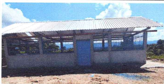
3. Láminas troquelada instaladas
