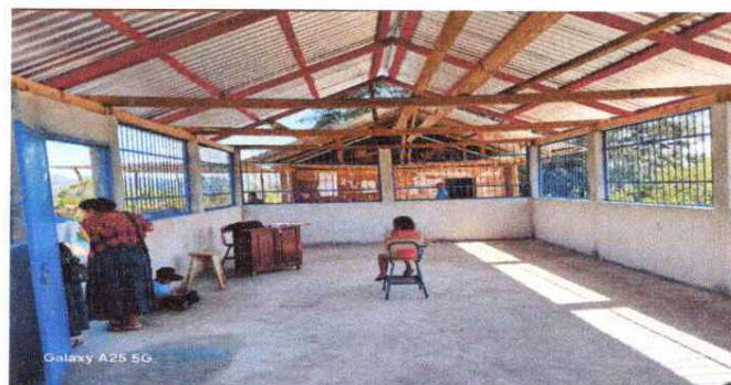
2. Piso de torta de concreto
