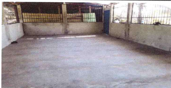
1. Piso de concreto aplicado
