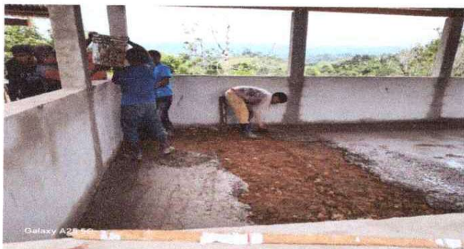
1. APLICACIÓN DE PISO DETORTA DE CONCRETO
