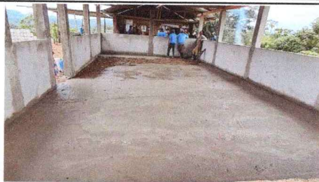
2. APLICACIÓN DE PISO DE TORTA DE CONCRETO
