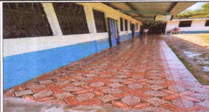
Foto 1: Culminación en la instalación del piso cerámico del corredor de la escuela.
