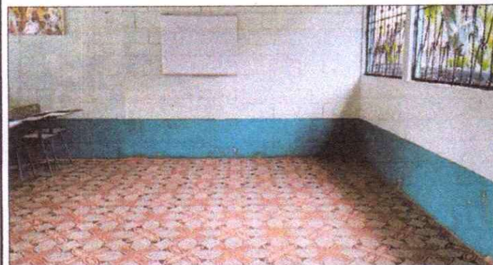
Foto 3: Finalización en la instalación del piso cerámico del aula de los grados de primero y segundo primaria.
