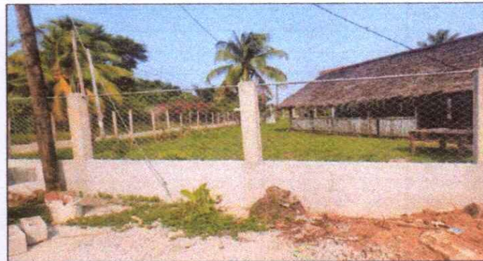
Foto 4: Terminación del trabajo en el lado izquierdo del muro perimetral del centro educativo.
