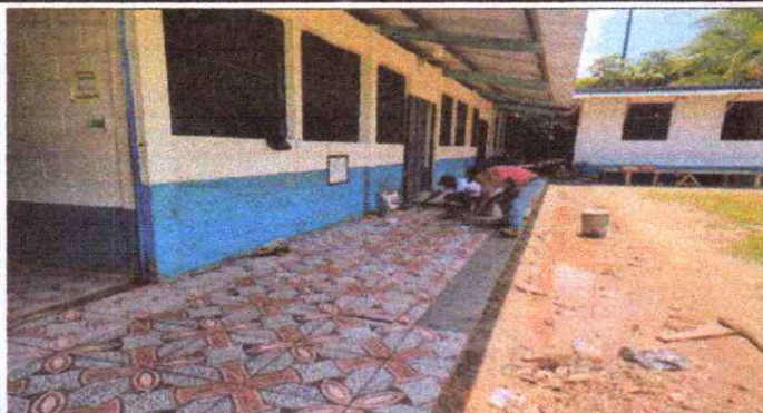
Foto 1: Instalando el piso cerámico en el corredor de la escuela.
