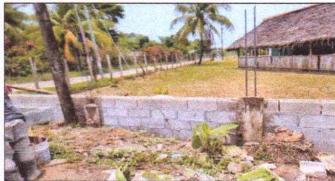
Foto 4: Pegado de block en el lado derecho del muro perimetral de la escuela.
