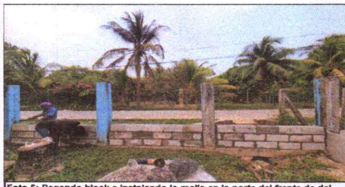
Foto 5: Pegando block e instalando la malla en la parte del frente de del muro perimetral de la escuela.
