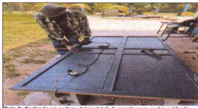
Foto 6: Cortando un pedazo del metal de la puerta para poder soldar la respectiva chapa.
