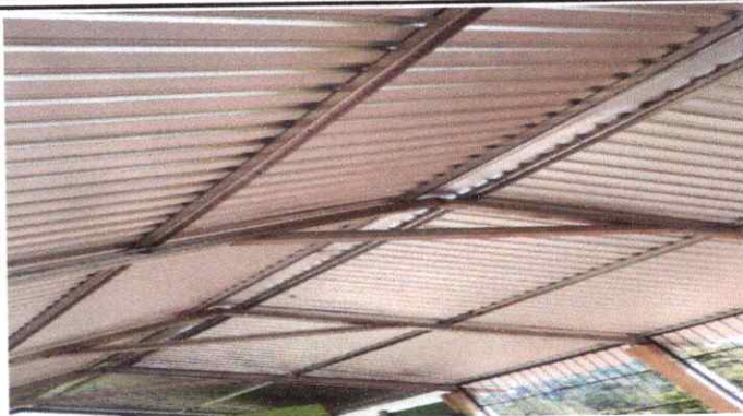
Lamina troquelada Instalada
