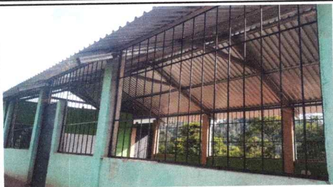
Instalación de Balcones Nuevos
