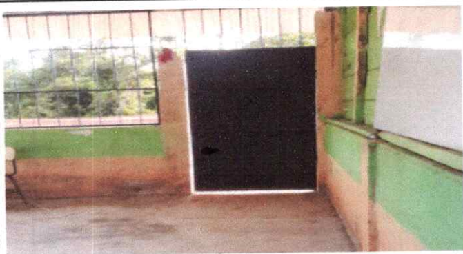
Instalación de Puerta de Metal
