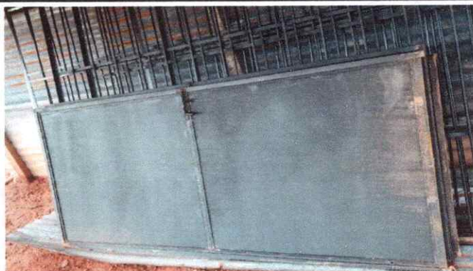
Reparación de Puerta y Balcones de Metal
