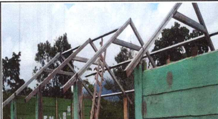
Instalacion de Estructura Metalica para lamina
