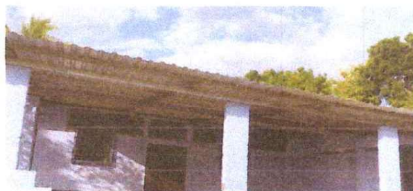
Foto 2. Se requiere cambiar el techo del centro educativo por lamina troquelada aluzinc calibre 26
