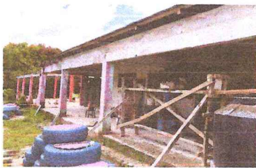
Foto 3: Repello de doscientos dieciseis metros de dos aulas delcentro educativo
