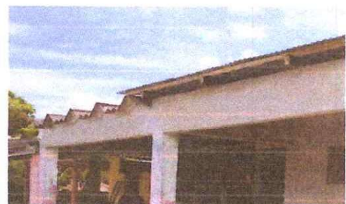
Foto 2: Cambio del techo den centro educativo por lamina troquelada
