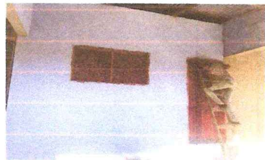
Foto 4: Pintura que se le aplico a la infraestructura del centro educativo
