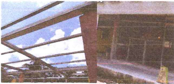
Foto1: Sustitucion de soporte del techo de madera por metal
