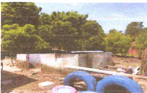
Foto 5: Cambio del techo, la puerta y la estructura de soporte de la cocina.
