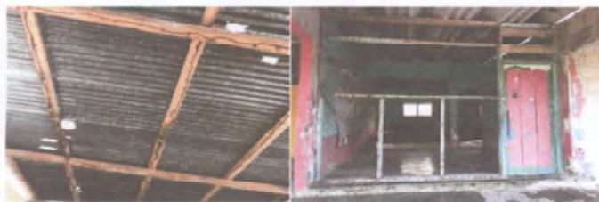
Foto 1. Se pretende sustituir el soporte del techo de madera por metal
