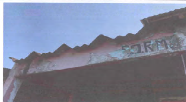
Foto 2. Se requiere cambiar el techo del centro educativo por lamina troquelada aluzinc calibre 26
