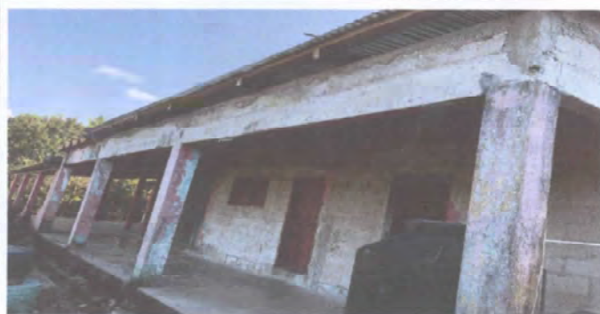
Foto 3 Se requiere material de repello para doscientos dieciséis m2 de dos aulas
