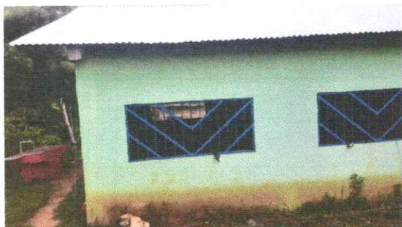
remozamiento de balcones
