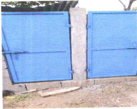
remozamiento de puerta
