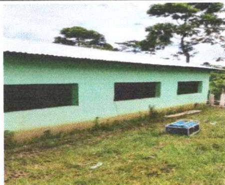
remozamiento de balcones
