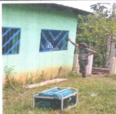
remozamiento de balcones
