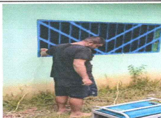
remozamiento de balcones
