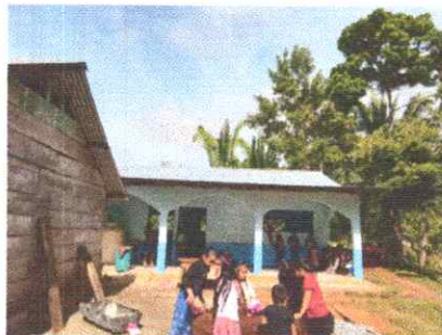
remozamiento de pintura
