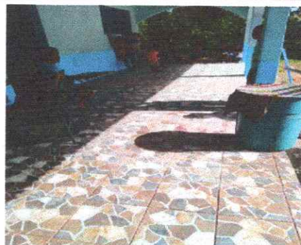
remozamiento de pintura
