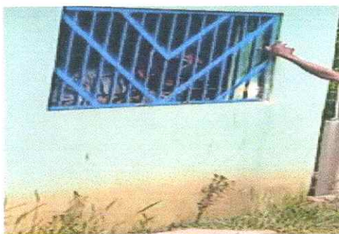
remozamiento de balcones
