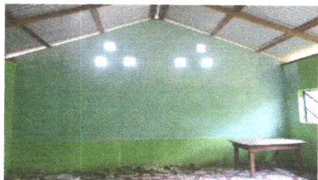
remozamiento de pintura
