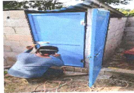
remozamiento de puerta
