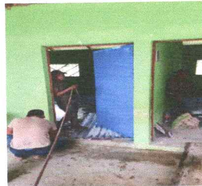
remozamiento de puerta
