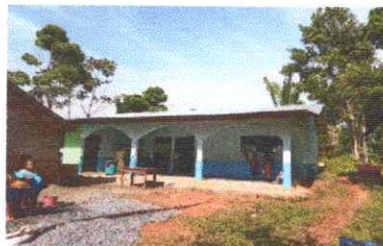
remozamiento de pintura
