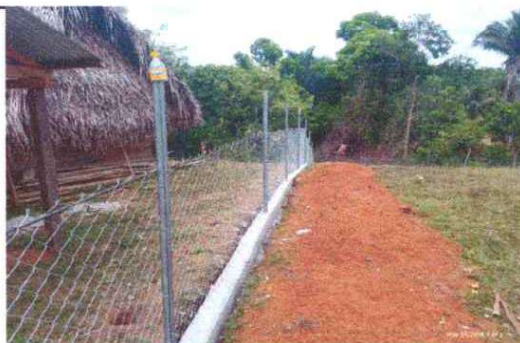
Foto 6: Parte sur del muro perimetral.
