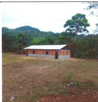
Foto 3: Aula de segundo y tercero primaria finalizada.
