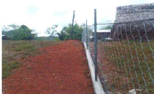
Foto 5: Parte este del muro perimetral.
