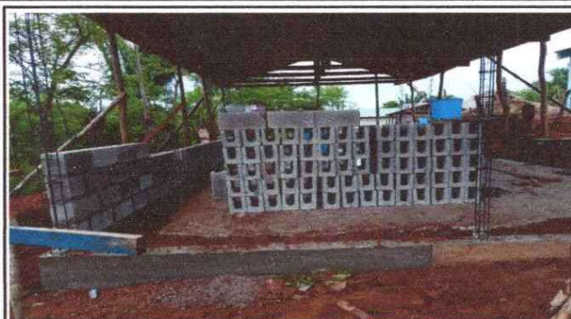
Foto 2: Pegado de block del aula de cuarto primaria.
