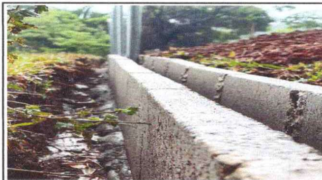
Foto 4: Pegado de solera del muro perimetral.
