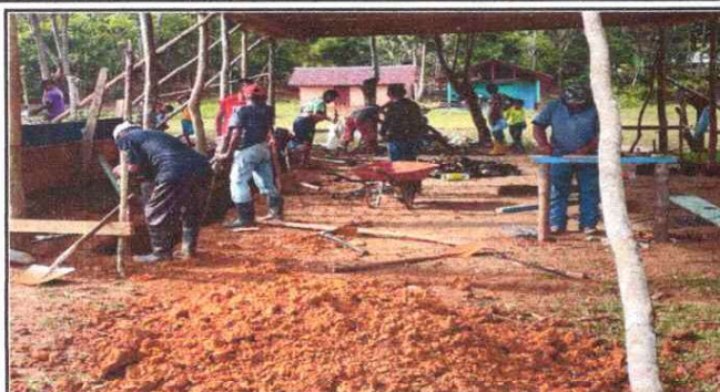
Foto 1: Fundicion del cimiento del aula de quinto primaria.
