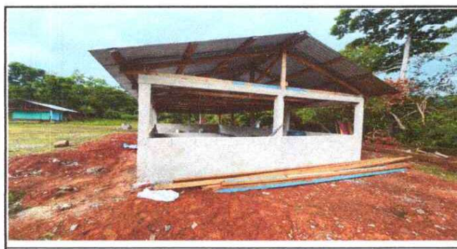
Foto 5: Fundicion de columnas del grado de segundo primaria.
