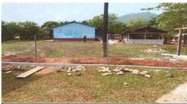
Foto 6: Colocacion de tubos para malla del muro perimetral.
