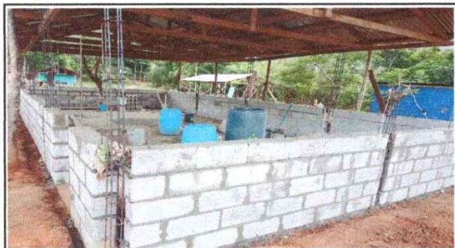
Foto 3: Fundicion de solera de los grados de cuarto y quinto primaria.
