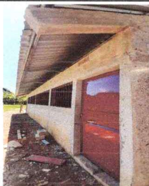
fotografía 4: Sustitución de puerta
