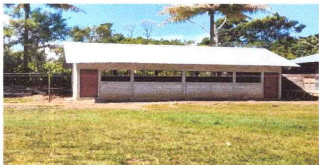
fotografía 1: Sustitución de lámina, por lámina troquelada aluzinc
