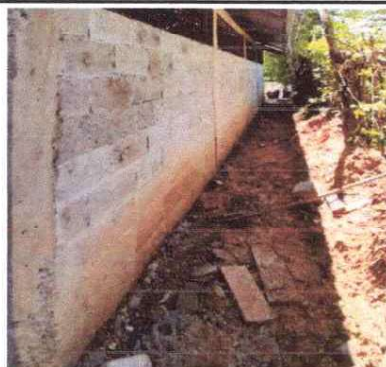
fotografía 2: fortalecimiento cimiento de humedad
