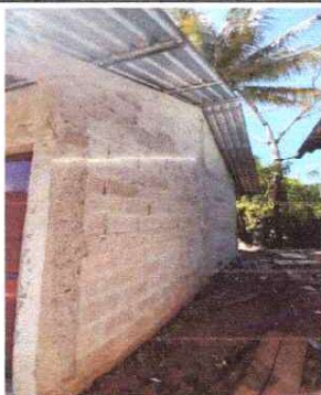
fotografía 3: Sustitución de madera a block
