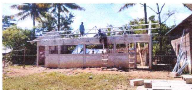
fotografía 6: Sustitución de estructura de soporte de madera, por metal
